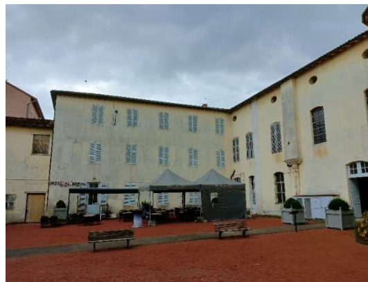
Figure 3 : Pied de bâtiment végétalisé dans la cour intérieure
