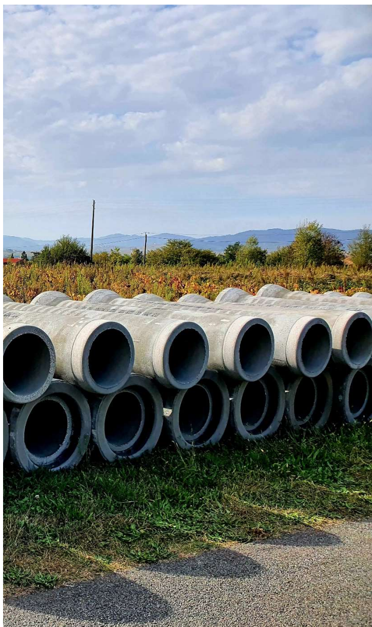
Stock de tuyaux d'assainissement en béton rue de Descours en vue de travaux de mise en séparatif - automne 2023
