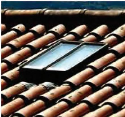
Châssis de toiture traditionnel, permettant d'accéder au toit
