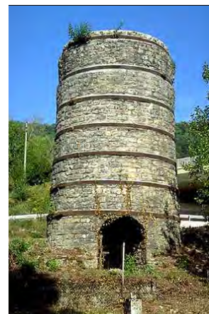
Four à chaux (Jura)
