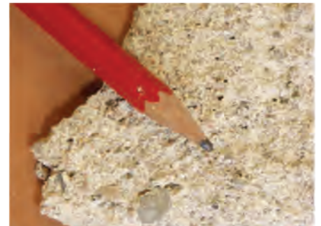
Mortier d'enduit de la fin du 18ème: les grains sont très variés (jusqu'à 10mm)
