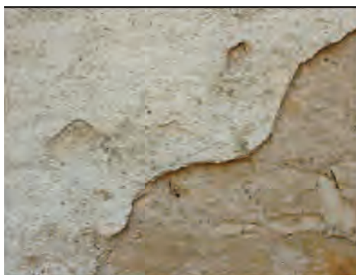
Enduit ancien se délitant et laissant apparaître ses différentes couches de l'enduit... Mortier réalisé au 19ème siècle avec une chaux hydraulique locale.
