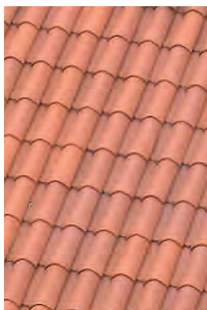
Toiture de tuiles romanes
