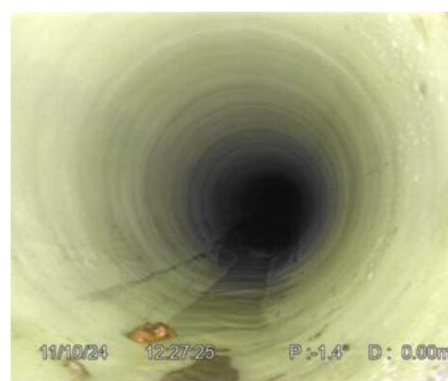
Photo du collecteur après réhabilitation
